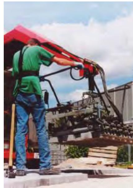
SISTEMA MOBILE CON PINZA PER LA POSA DI PAVIMENTAZIONI
